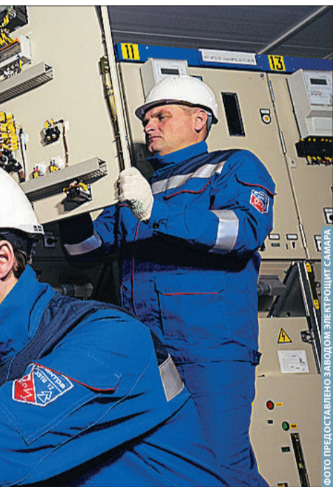
ФОТО ПРЕДОСТАВЛЕНО ЗАВОДОМ ЭЛЕКТРОЩИТ САМАРА
